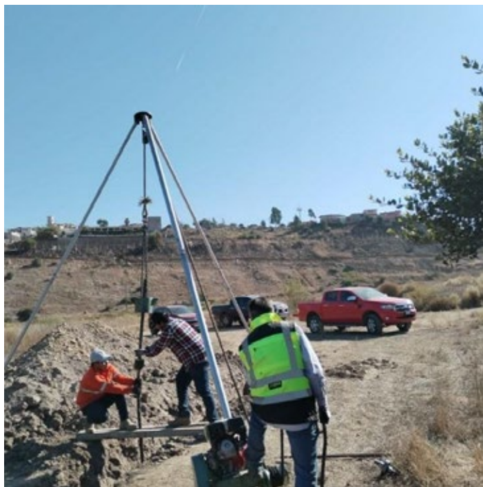
Vista panorámica de pruebas de penetración estándar
