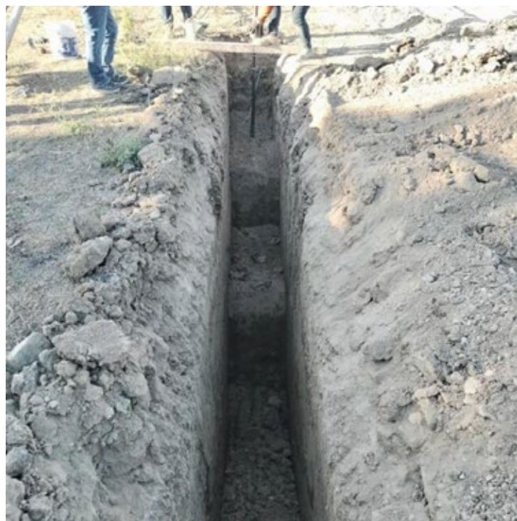
Vista panorámica de excavación de sondeo y perfil estratigráfico
