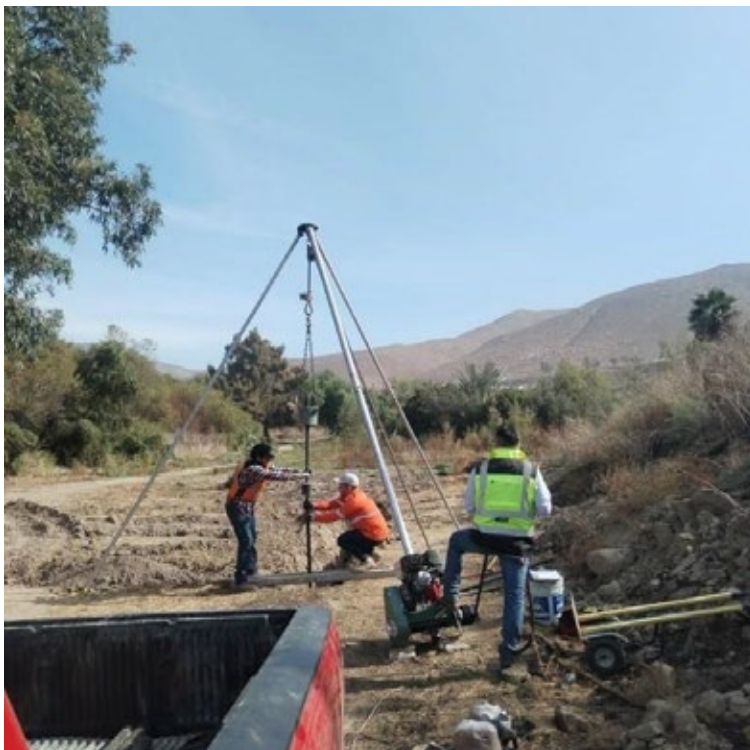
Vista panorámica de pruebas de penetración estándar
