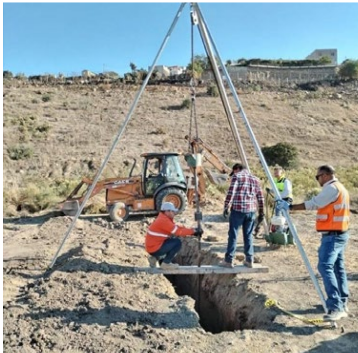
Vista panorámica de pruebas de penetración estándar SPT 4
