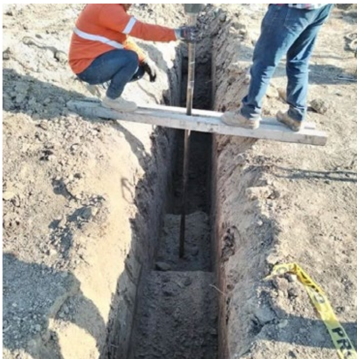
Vista panorámica de pruebas de penetración estándar
