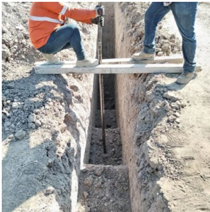
Vista panorámica de pruebas de penetración estándar
