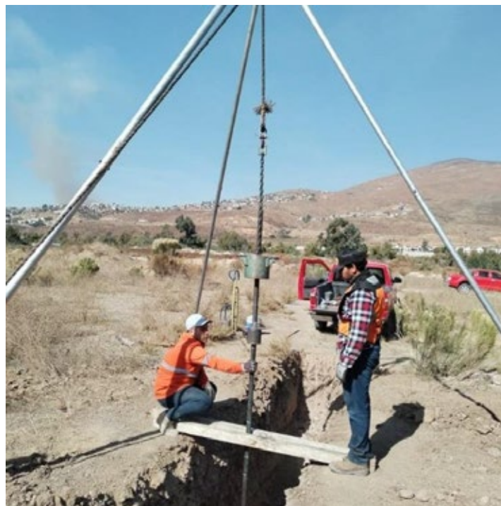
Vista panorámica de pruebas de penetración estándar
