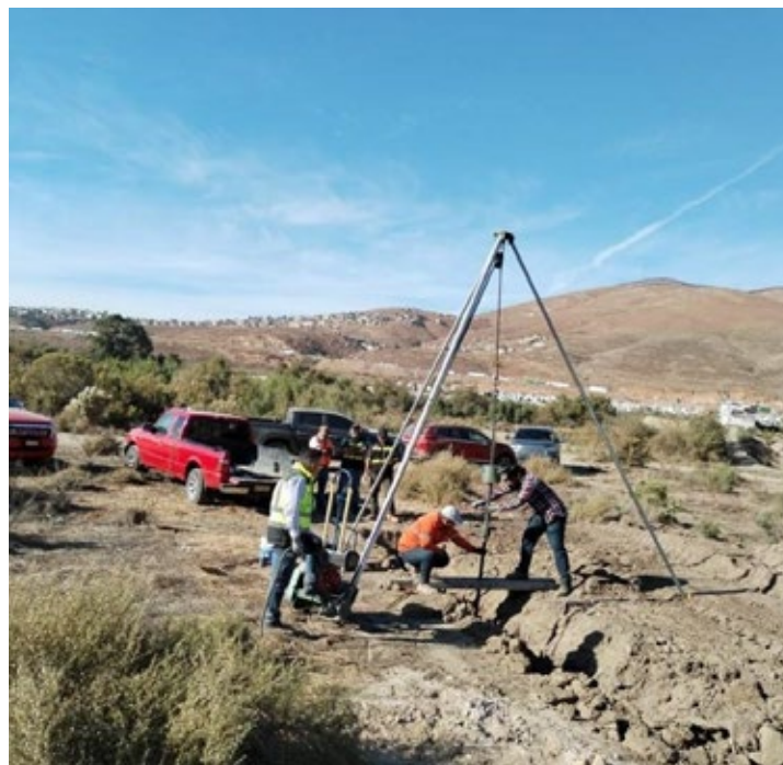
Vista panorámica de pruebas de penetración estándar
