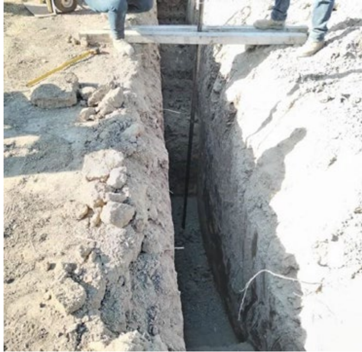
Vista panorámica de pruebas de penetración estándar
