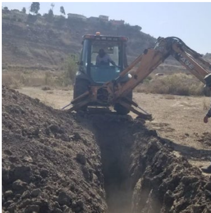
Vista panorámica de pruebas de penetración estándar SPT 6
