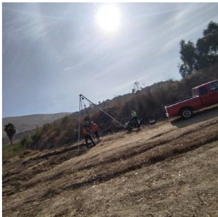
Vista panorámica de pruebas de penetración estándar
