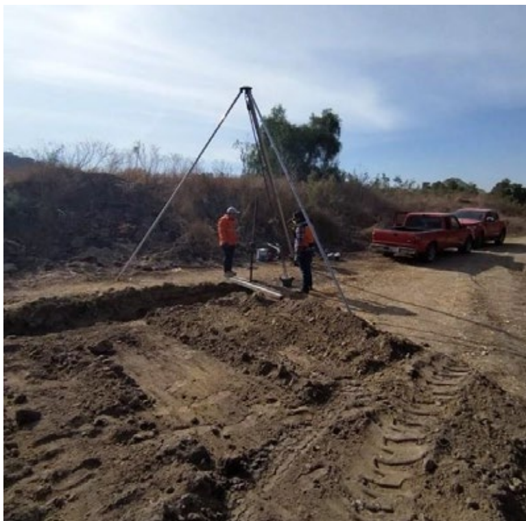
Vista panorámica de pruebas de penetración estándar SPT 1
