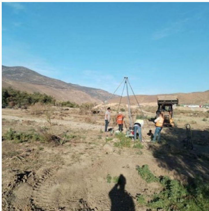
Vista panorámica de pruebas de penetración estándar SPT 5
