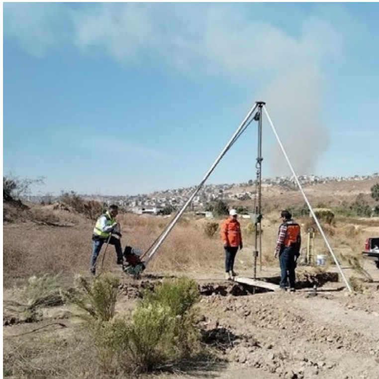
Vista panorámica de pruebas de penetración estándar SPT 2
