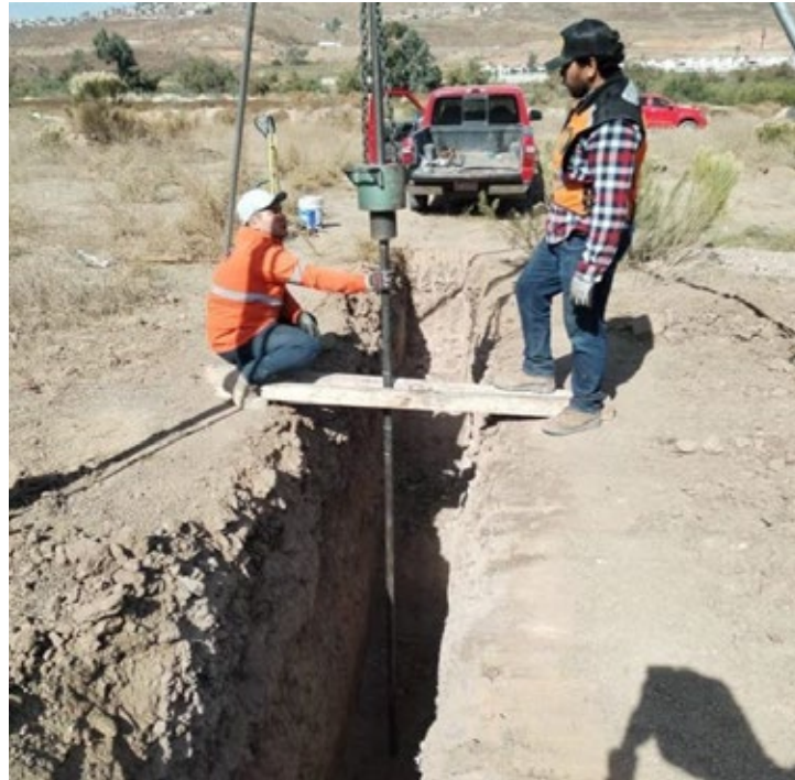
Vista panorámica de pruebas de penetración estándar
