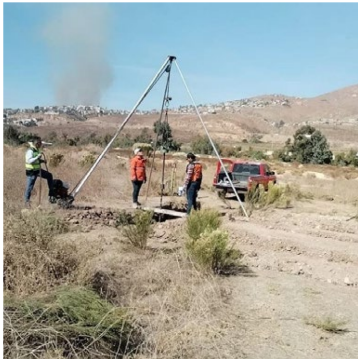
Vista panorámica de pruebas de penetración estándar
