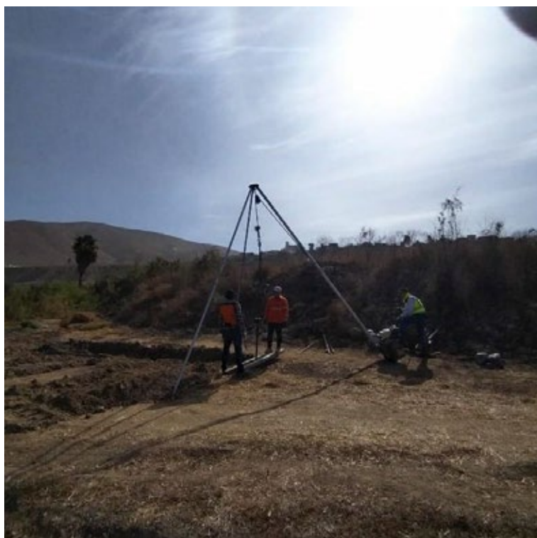
Vista panorámica de pruebas de penetración estándar
