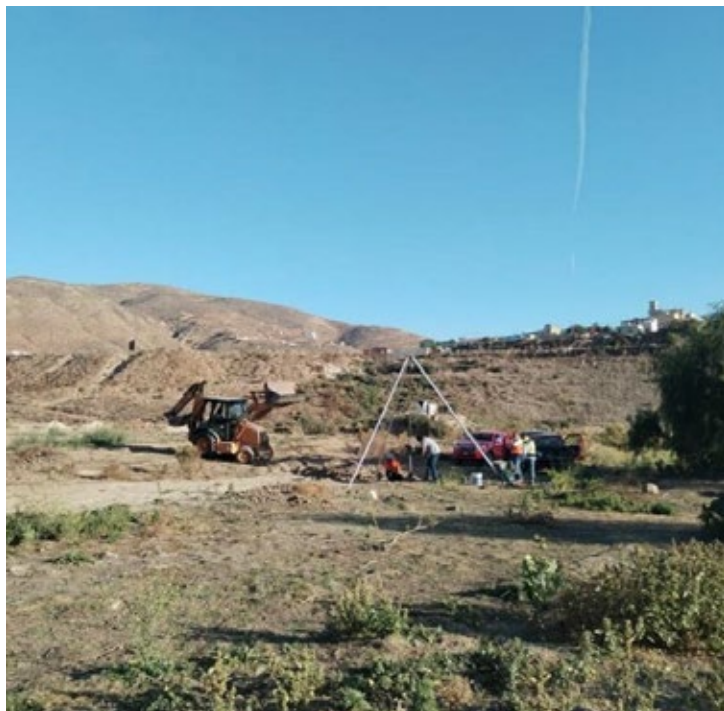
Vista panorámica de pruebas de penetración estándar
