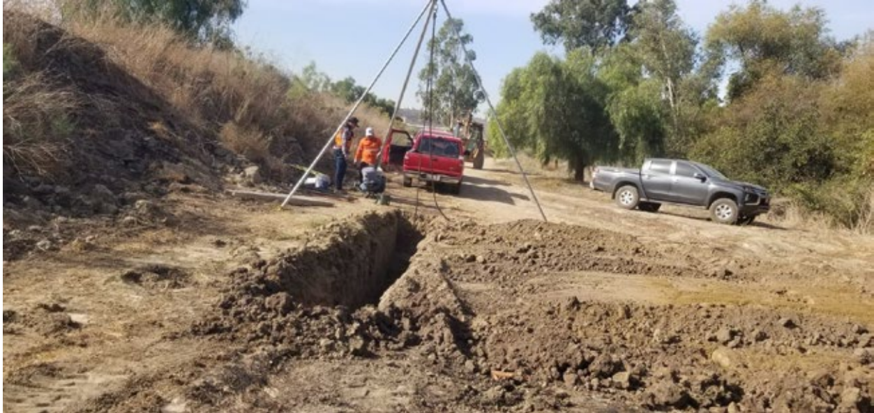
VISTA PANORÁMICA DE LA ZONA EN ESTUDIO
